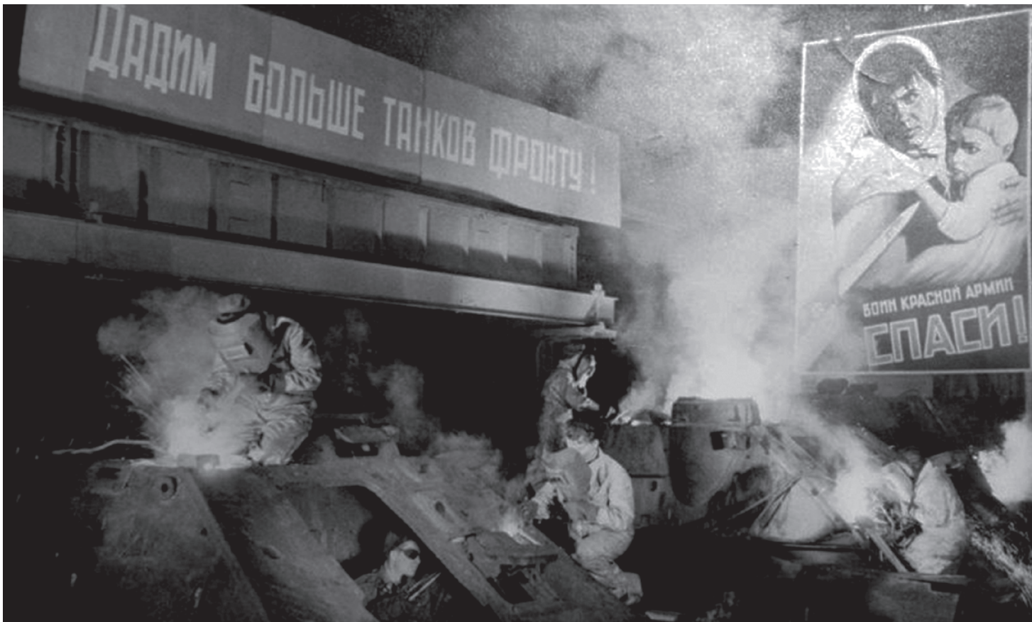
Сварка корпусов САУ СУ-122 (на переднем плане) и СУ-100 на Уралмашзаводе
