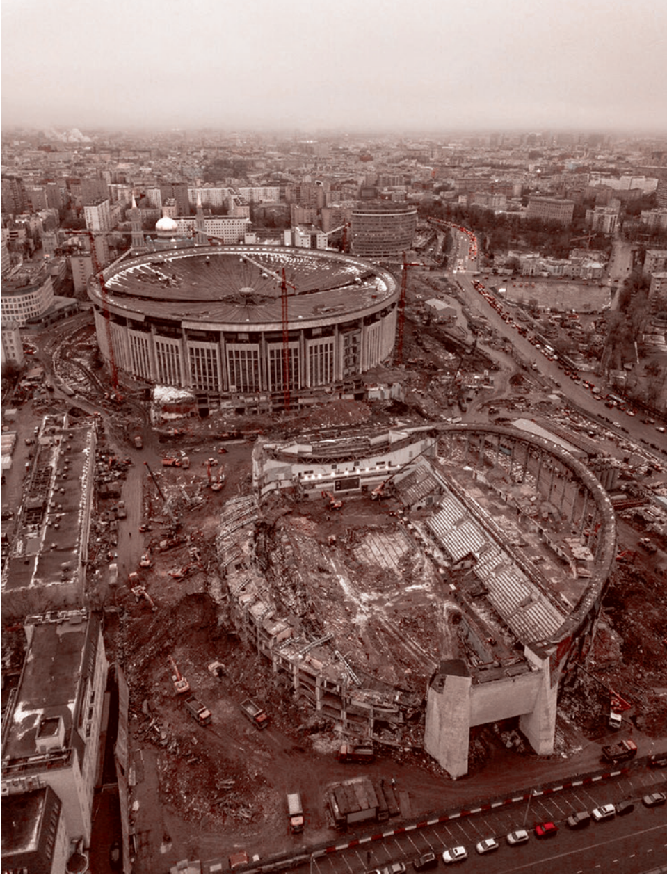
Разрушение спорткомплекса Олимпийский
