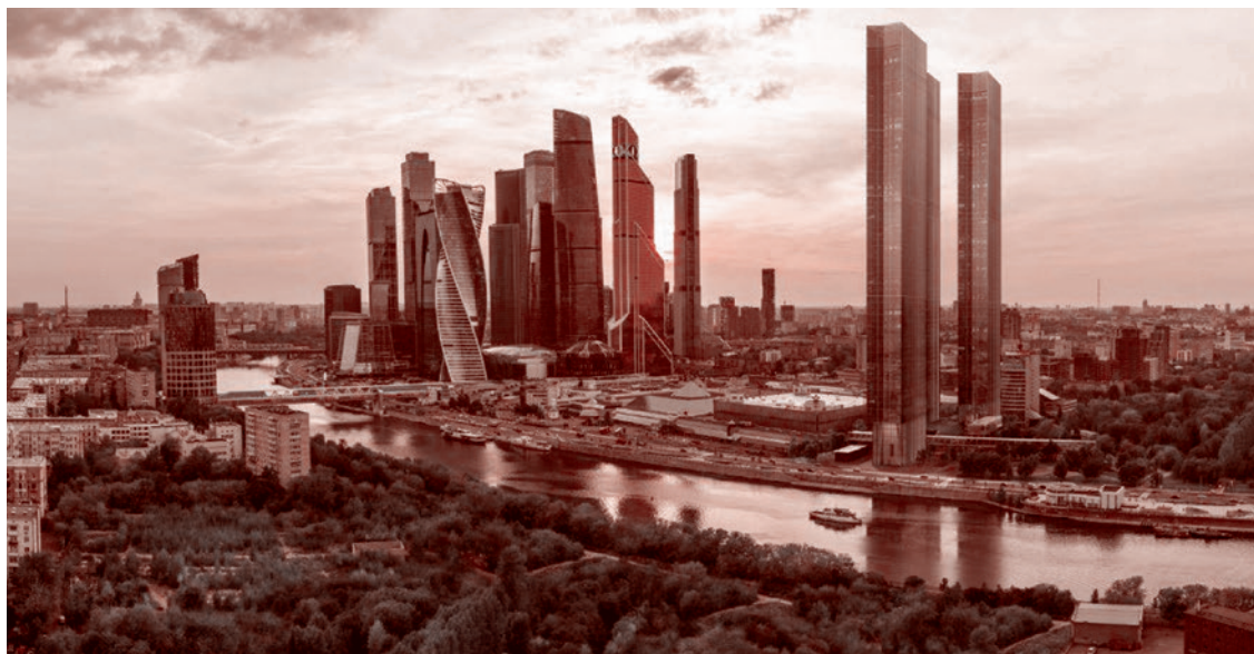
Вид на «Москва-Сити» и Capital Towers
