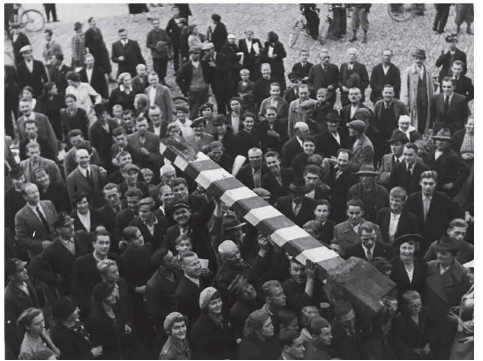
Разрушение погранзаставы после захвата Заользя, 1938
