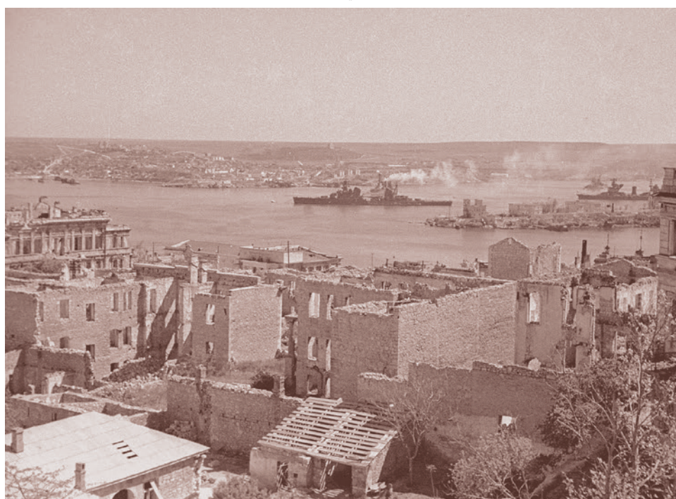
Легкий крейсер «Ворошилов» и линкор «Парижская коммуна» в Севастопольской бухте. В кадре разрушенные дома в районе Северной бухты и Павловского мыса. 1942
