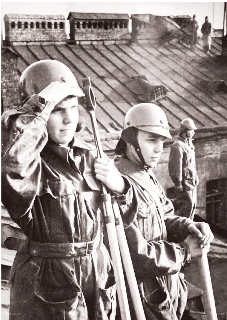
Ленинградские школьники, бойцы МПВО, дежурят на крыше дома. 1941
