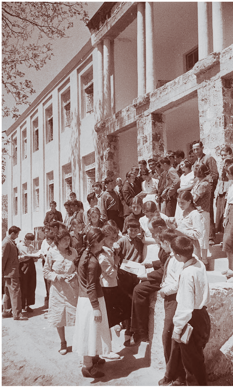
У строящейся школы Юного техника в Конде. Ереван. 1939 г. (Фото: С.О. Фридлянд)
