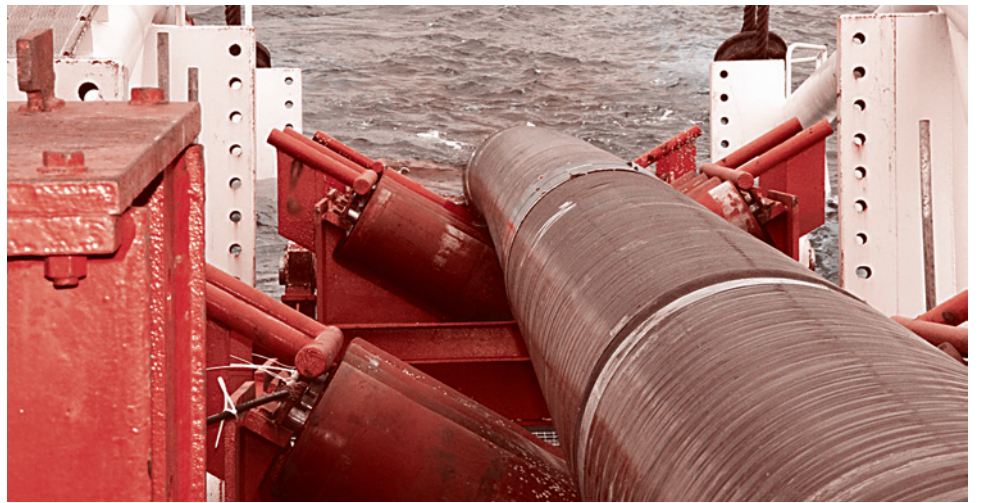
Строительство морского участка газопровода «Джубга-Лазаревское-Сочи». Фото с сайта gazprom.ru
