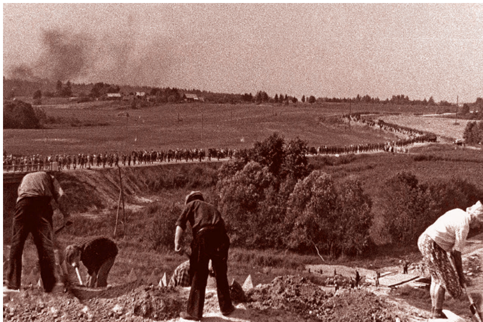
Ленинградцы на строительстве Лужского рубежа. Лето 1941 г.
