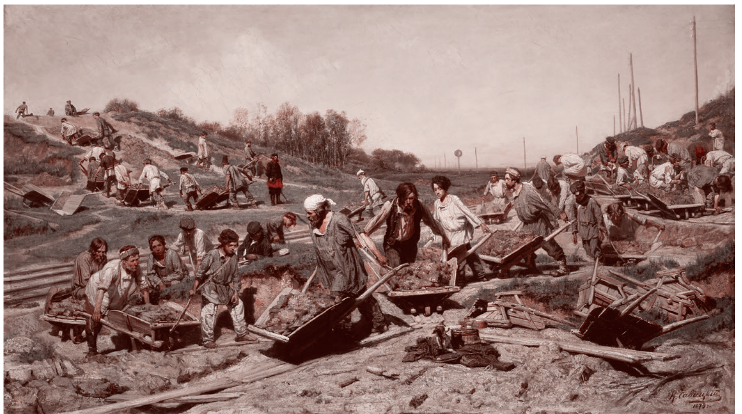
Константин Савицкий. Ремонтные работы на железной дороге. 1874
