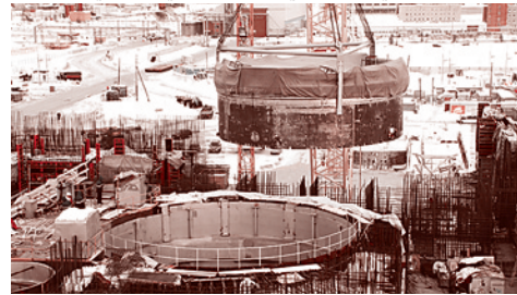
Строительство 4-го энергоблока Белоярской АЭС с реактором на быстрых нейтронах БН-800
